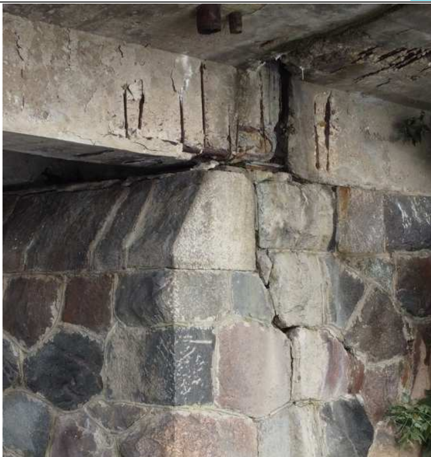
15 pav. Išplautos mūro siūlės dėl nesandarios deformacinio pjūvio konstrukcijos
