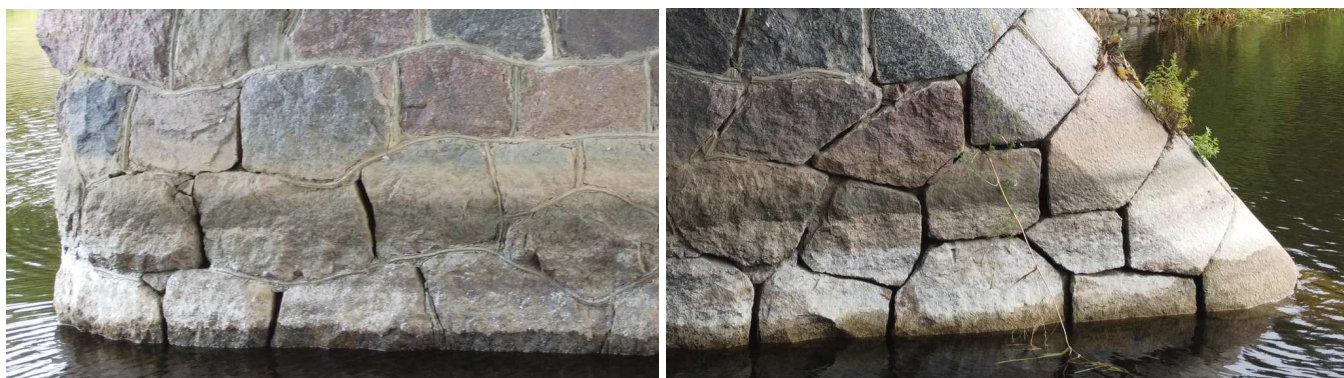
16 pav. Vandens lygio kritimo zonoje siūlės tarp akmens mūro ištrupėjusios, išplautos
