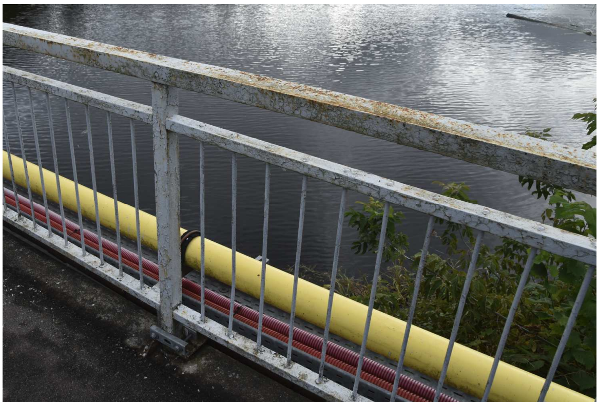
6 pav. Sutrūkinėjusi metalinių turėklų dažų danga, matomi taškinės korozijos židiniai
