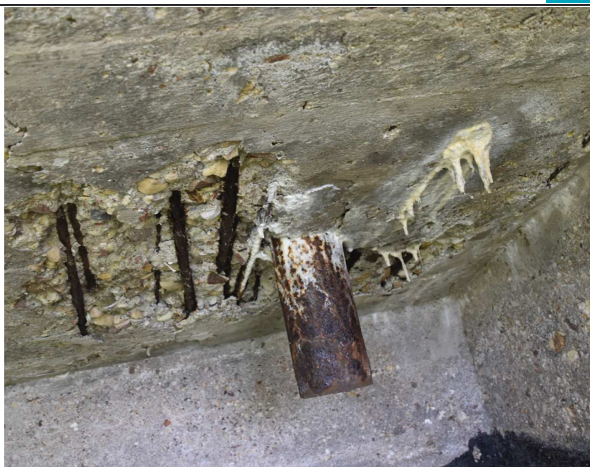
9 pav. Dėl nesandarios šulinėlio jungties su hidroizoliacija vanduo sunkiasi per kraštus, matomi iš betono plaunamų karbonatų varveliai. Matoma dėl per mažo apsauginio sluoksnio korduojanti plokštės armatūra
