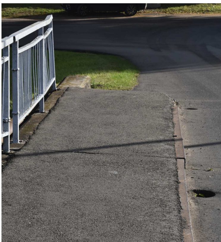
4 pav. Šalutė, danga – asfaltas (naujai paklotas)
