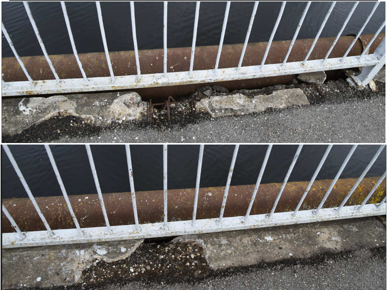
5 pav. Šaltilčių kraštai vietomis smarkiai pažeisti, aptrupėjęs betonas, matoma korduojanti armatūra
