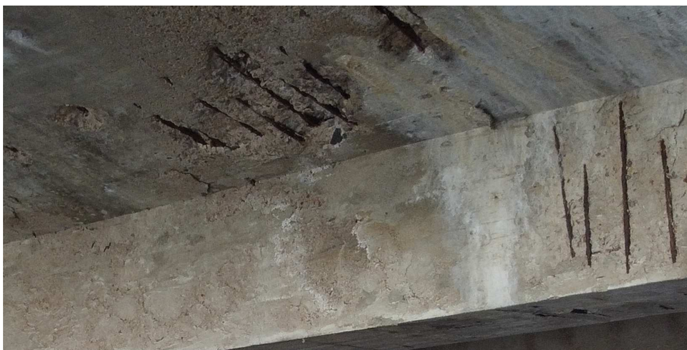
10 pav. Perdangos paviršiai porėti, susidarūsios ertmės, matoma korduojanti armatūra
