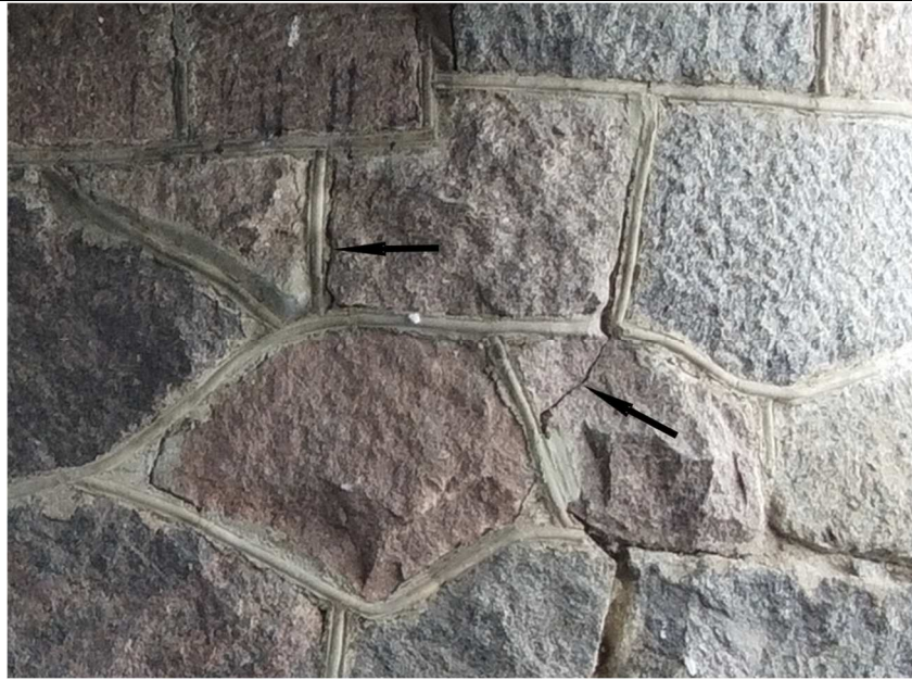
17 pav. Įtrūkusios mūro siūlės ir mūro akmuo
