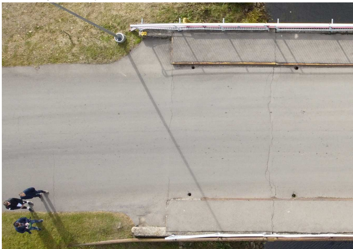
3 pav. Ties deformaciniais pjūviais susidarę plyšiai
