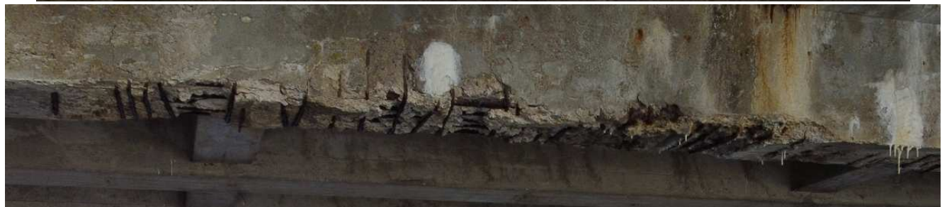
8 pav. Tilto hidroizoliacija nesandari, vanduo skverbiasi per perdanga ir plauna iš betono karbonatus. Matoma dėl per mažo apsauginio sluoksnio korduojanti skersinė ir išilginė armatūra
